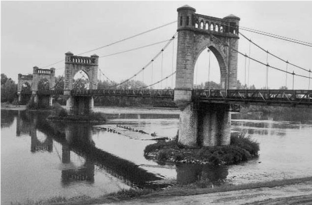
Brücke bei Langeais
